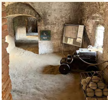
Scorcio delle casematte del Rivellino
